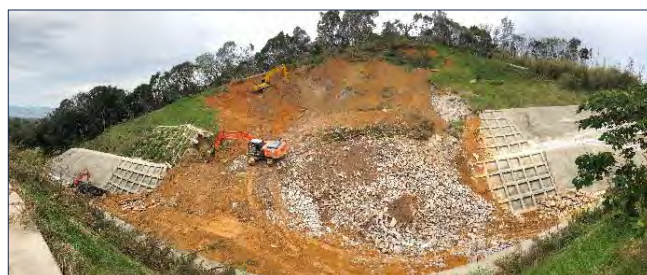
豪雨により崩落した法面の様子 左：道路面より 下：崩落対岸からのパノラマ写真
