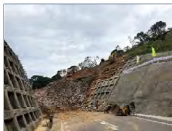
豪雨により崩落した法面の様子 左：道路面より 下：崩落対岸からのパノラマ写真
