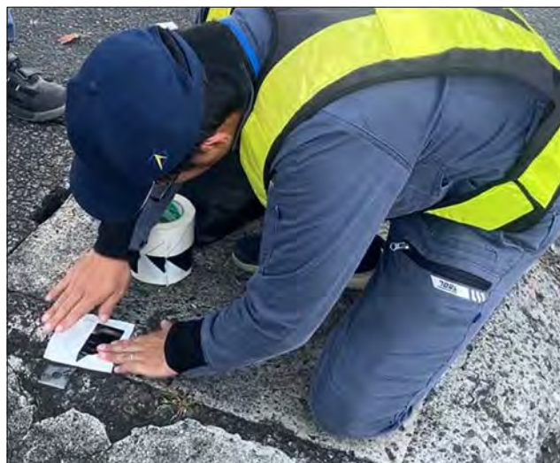
「荒れたコンクリート面にも密着」
